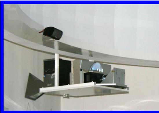
Se trata de un sistema de proyección digital con imágenes a composición de proyectores. Toda la cúpula viene iluminada por la composición de dos proyectores de alta resolución que forman parte del sistema especial de video proyección, compuesta del conjunto de ópticas especiales, ubicadas centralmente en un único bloque o a los lados de la cúpula dividido en dos partes, dejando de
