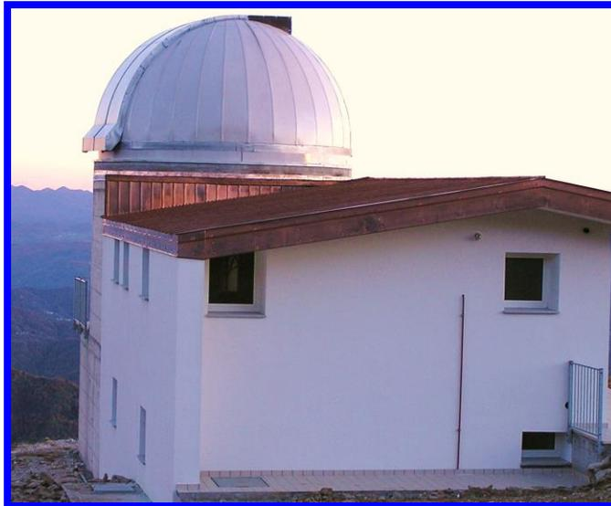
La costruzione del telaio in Rotazione e di sostegno è tutta in tubolare metallico zincato e la copertura è in lamiera di alluminio, dello spessore di min. 12/10 per i modelli di diametro fino a mt 3,12 e di 15 / 10 per il diametro da 4 a 5 mt. La cupola potrà essere fornita vernice del colore da Voi desiderato nel range dei RAL disponibili.
